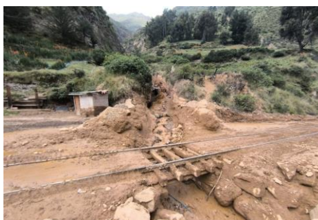
IMAGEN 03: SE MUESTRA A LA SLAIDAD DE LA QUEBRADA COLMATADO DE SEDIMENTOS
